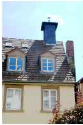
„Nothkirche“ Hinterhof Hauptstraße 22
