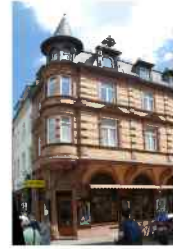
Eckhaus Akademiestraße vorkragendes OG
